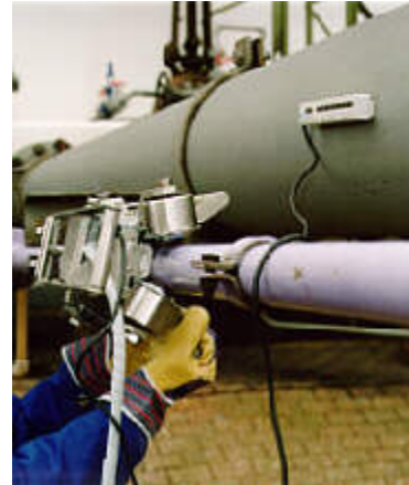
Obr. 18 - Nastavenie skenera na potrubí
