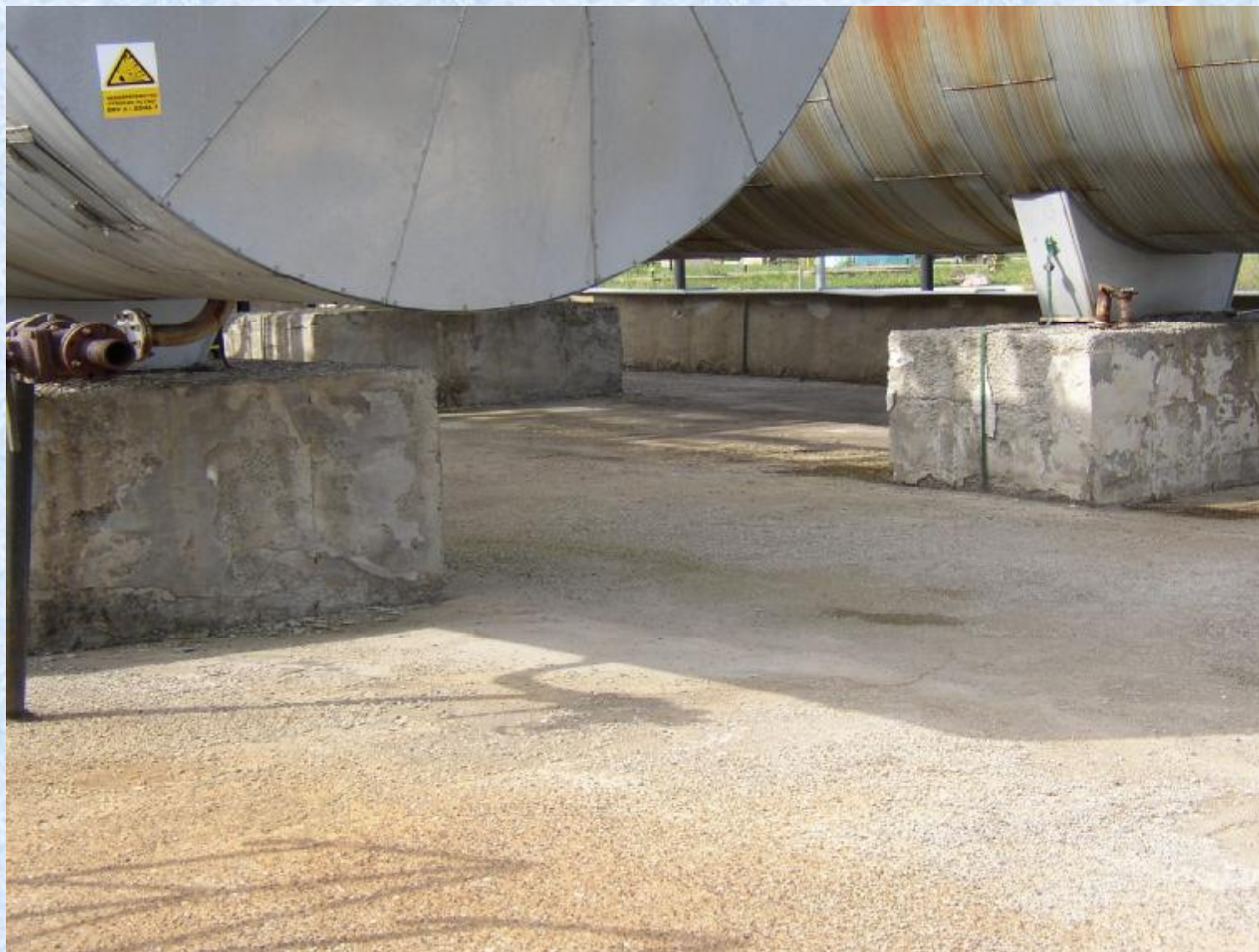
Obr. 8.1 Záchytná vaňa pod nádržami pripravená na skúšku vodotesnosti
