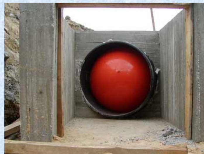
Obr. 9.2 Súprava vakov na skúšku tesnosti ← kanalizácie
