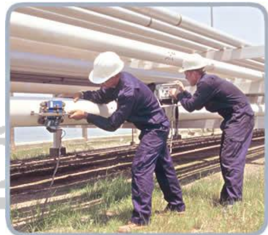
Obr. 2.2.4 UT skener na potrubí
