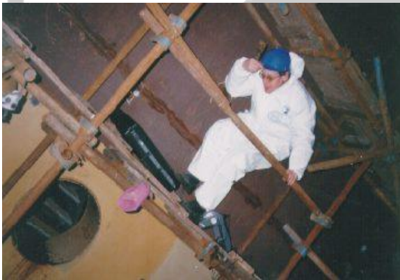
Obr. 4.5 Lešenie von veľkoobjemovej nádrži Obr. 4.6 Vyznačenie bodov pre UTT
